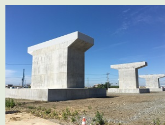
宮城県石巻市 鎮守大橋の橋脚
