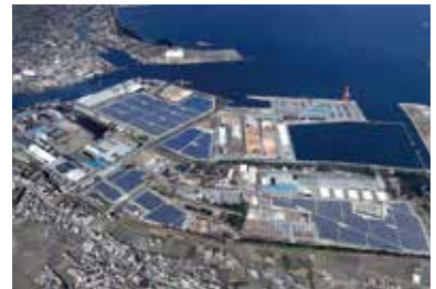
小松島太陽光発電所(モジュール容量2.1万KW)
