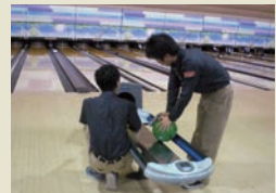
設備の点検・清掃
