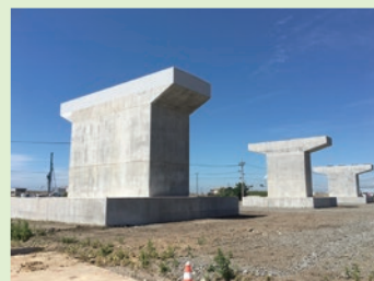
宮城県石巻市 鎮守大橋の橋脚
