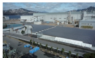
大竹工場太陽光発電設備
