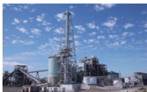
石巻雲雀野発電所
