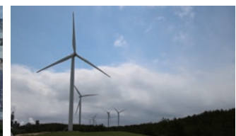
秋田風力発電所
