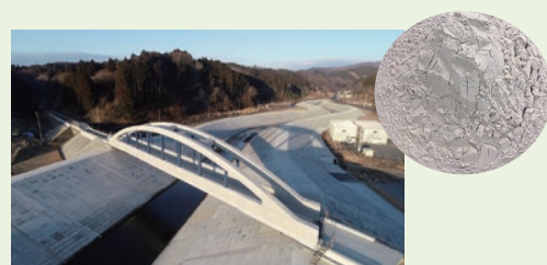
JR気仙沼線桜川橋梁(宮城県本吉郡南三陸町)橋桁、アーチ部、縦鋼にCfFA®を使用
