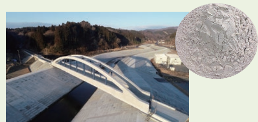
JR気仙沼線桜川橋梁(宮城県本吉郡南三陸町)橋桁、アーチ部、縦鋼にCfFA®を使用
