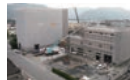
八代バイオマス発電(建設中)
