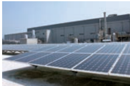
大竹工場の太陽光発電設備
