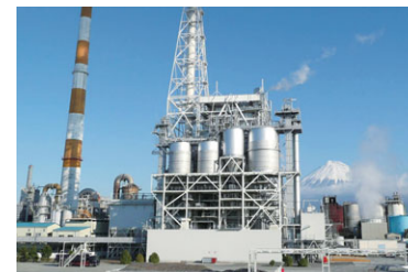
バイオマスボイラー
