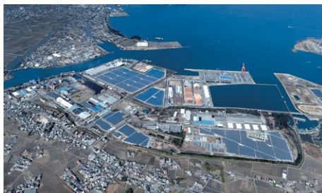
小松島太陽光発電所
