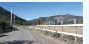
設置したフェンス
