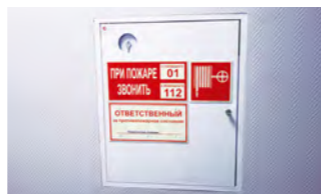
オフィス内に設置された消火設備
