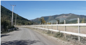
設置したフェンス
