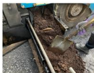
常温アスファルト乳剤混合物の施工テストの様子
