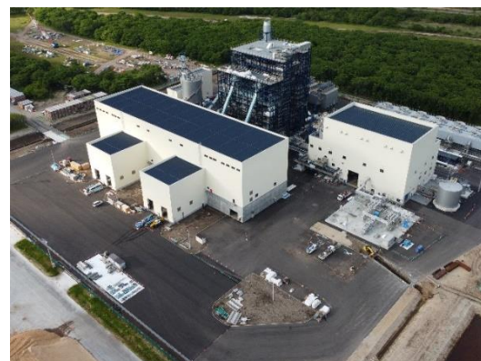
完成間近の勇払エネルギーセンター
