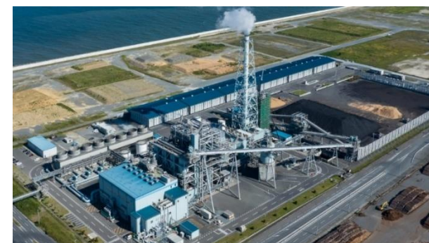
バイオマス混焼比率を拡大する 日本製紙石巻エネルギーセンター
