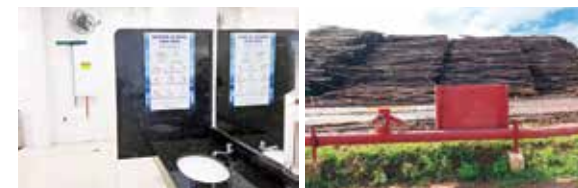
（左）清潔に保たれている事務所トイレ （右）原木保管ヤード内に設置された消火栓
