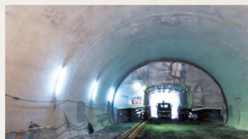
CfFA ® が試験打設された「八雲第1トンネル」
