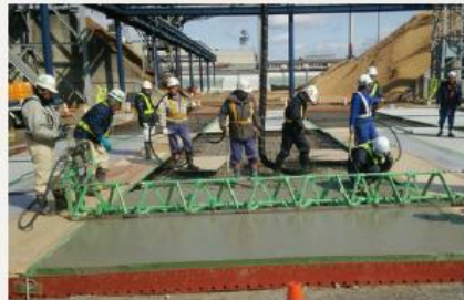
試験施工中の CfFA ® 配合「1DAY PAVE」
