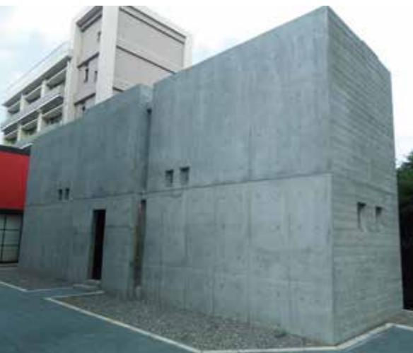
写真-1:CfFAコンクリートを用いた実物大のRC造住宅模型
