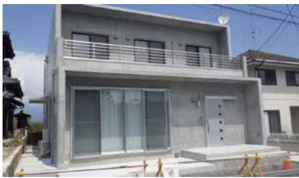
写真-1: 建築試験棟 40-18-20N(CfFA 内割換算 15%配合)
