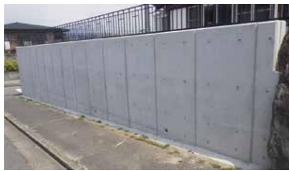
写真-2: 土木擁壁 27-18-20N(CfFA 内割換算 30%配合)
