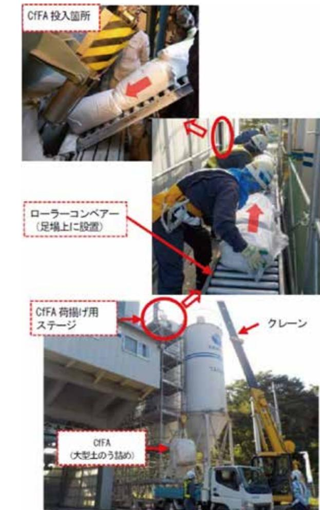
写真-1: CfFA投入設備
