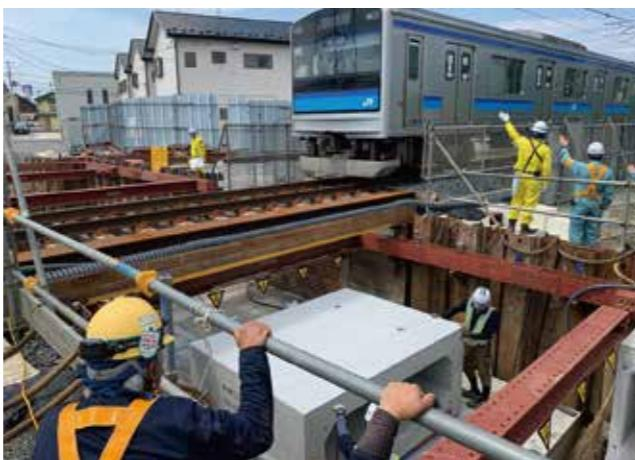
写真-2:ボックスカルバート設置工事
