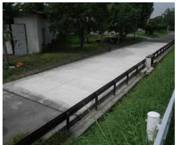
写真-2:CfFAコンクリートを用いたコンクリート舗装
