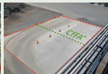
完工した「1DAY PAVE」(192m 2 :手前)と「1DAY PAVE + CfFA ® 」(192m 2 :奥)
