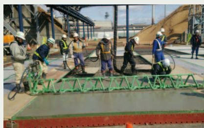
試験施工中の CfFA ® 配合「1DAY PAVE」
