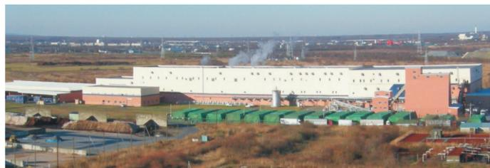
原材料から抄紙・出荷までが直線に配備されている勇払6号マシンの建屋
