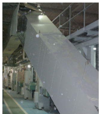
PPC工場ダクト落下
