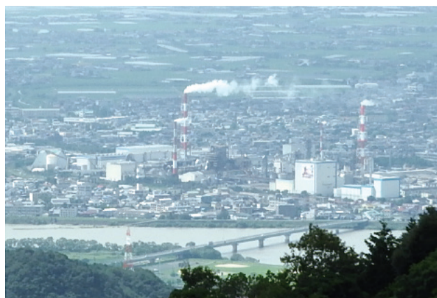
再稼働後の八代工場
