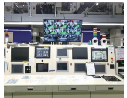
輪転機操作パネル
