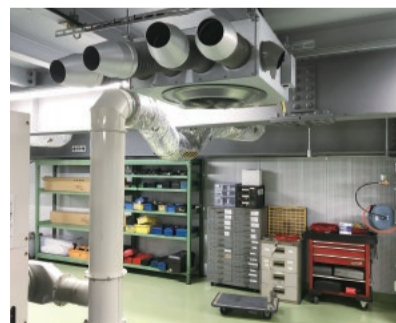
新空調システム
