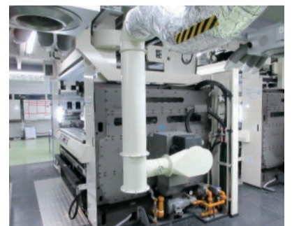
新空調システム
