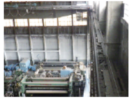
1号機天井クレーンレール変形／修復後
