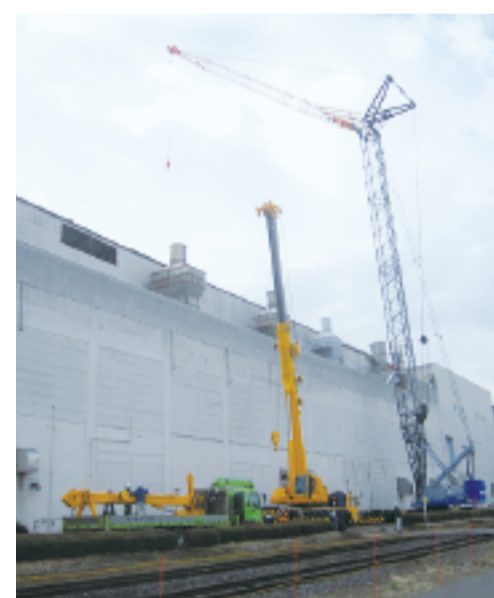
大型クレーン作業の様子
