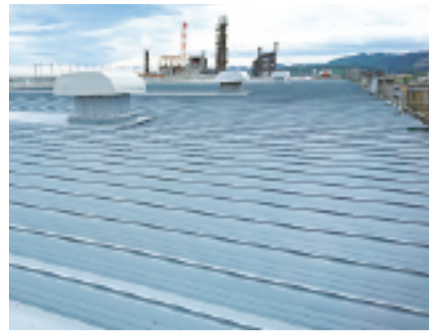
4号機建屋屋根／修復後
