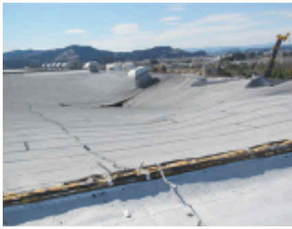
4号機建屋屋根／修復前
