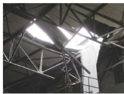
4号機建屋一部崩落
