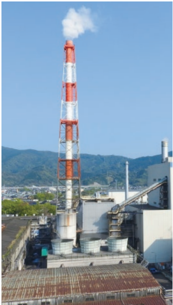
八代9号微粉炭ボイラー
