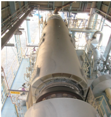
【CfFA ® 製造設備】 未燃カーボンを外熱式キルンにて燃焼除去
