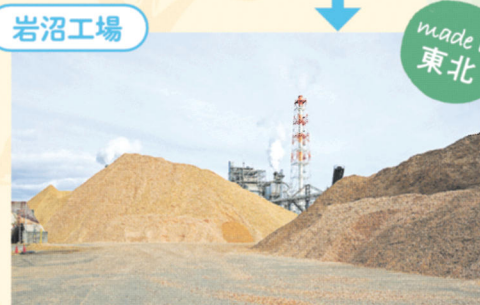
原料となる木材チップを敷地内に一時保管
